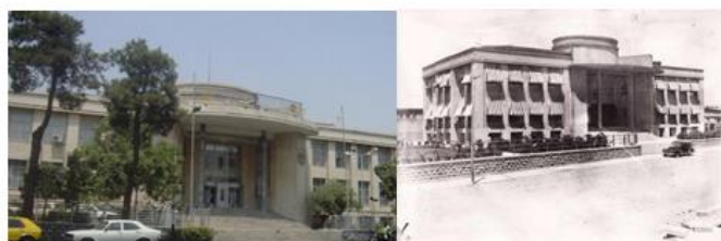
[شکل ۲. کارخانه دخانیات تهران (سالنامه دنیا، ۱۳۵۳) و ساختمان بنگاه یا سبک آرت دکو که ورودی بنایی ملهم از معماری مدرن باوهاوسی است]
