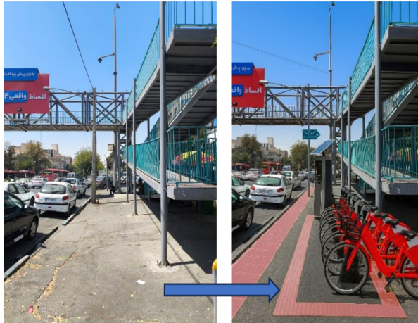
احداث ایستگاه دوچرخه در ورودی خیابان - قبل و بعد
