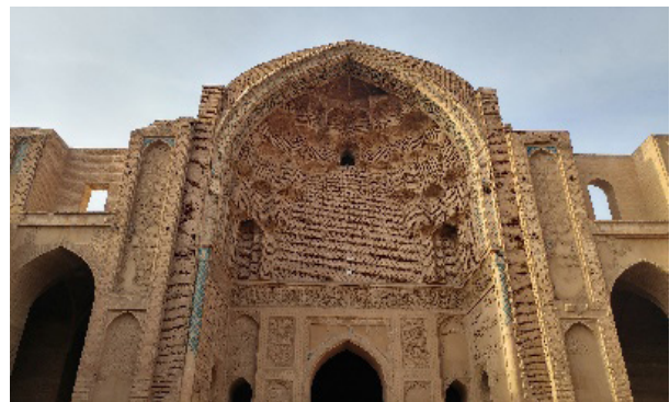
تصویر ۱. تزئینات آجرکاری باتکه‌های لعابی
