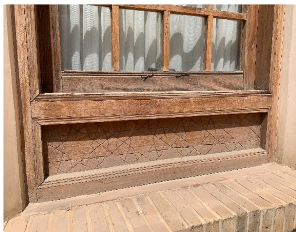
تصویر ۵. ساختار یکی از پنجره‌های خانه عامری‌ها کاشان
