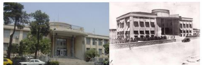
[شکل ۲. کارخانه دخانیات تهران (سالنامه دنیا، ۱۳۵۳) و ساختمان بنگاه یا سبک آرت دکو که ورودی بنایی ملهم از معماری مدرن باوهاوسی است]
