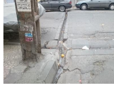
تصویر ۲- وضعیت جوی‌ها، اختلاف سطح‌های مسیر پیاده و سواره
